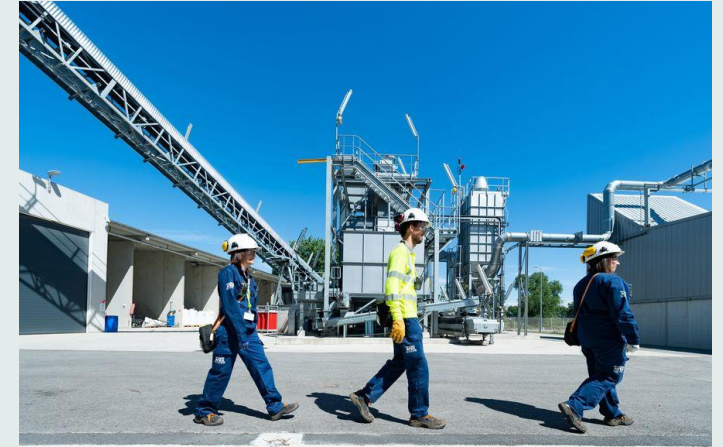
Plateforme GAYA d'Engie en région Rhône-Alpes Crédit photo : © ENGIE / SCOPE PRODUCTION / MEYSSONNIER ANTOINE
