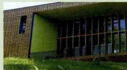
Projet Bilita-Garbi avec sa façade démontable réalisée en palettes de récupération.
